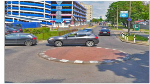
Пример конструктивно выделенного тротуарной плиткой мини-кольца
